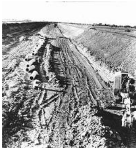
FIG. 10 – Le chantier de l'autoroute
